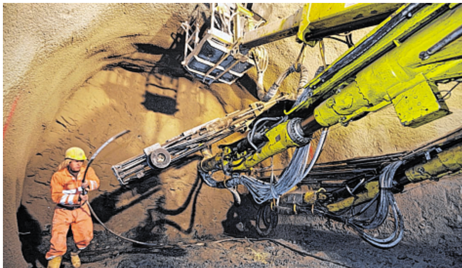
Bevor der Basistunnel gebohrt werden konnte, wurden Unmengen an Papier produziert.
