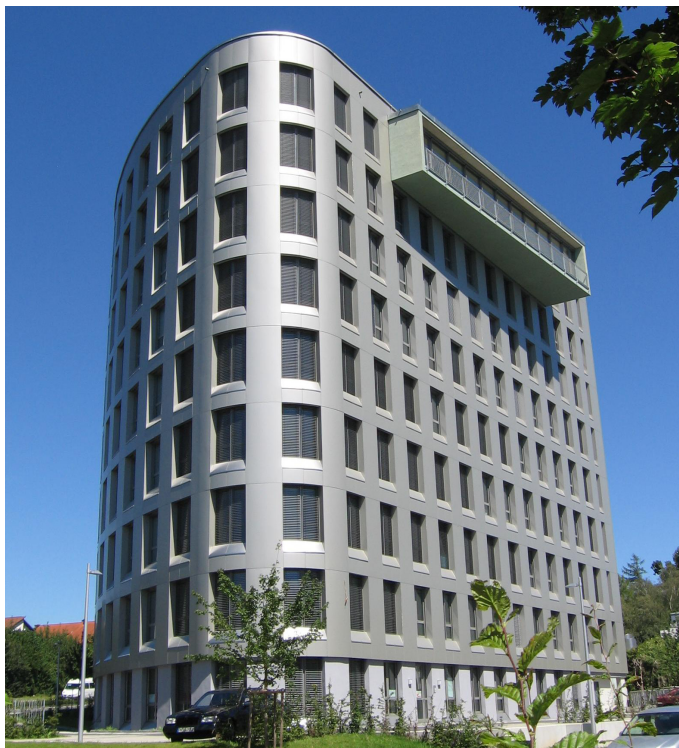
Erfolgreiches PPP-Projekt: Landratsamt Friedrichshafen (Fränkel AG)
